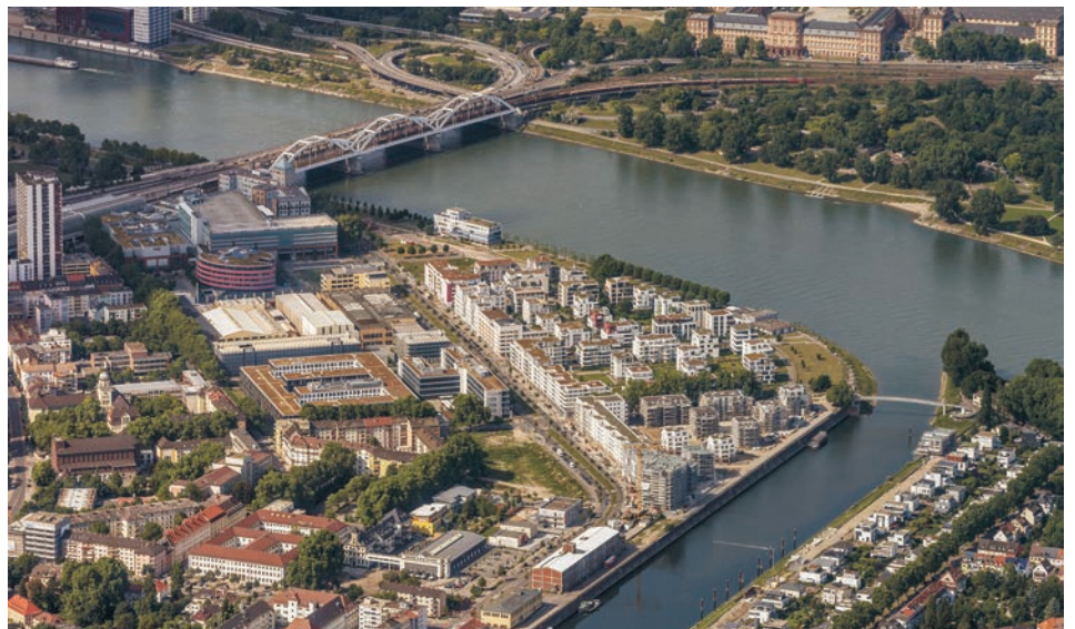
Das Rheinufer in Ludwigshafen mit neuer Bebauung
