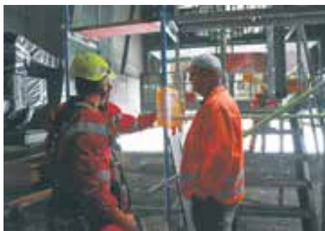
Auch die Höhenretter der Feuerwehr Mannheim besichtigen die Baustelle, üben und sichten Möglichkeiten für einen Ernstfall
