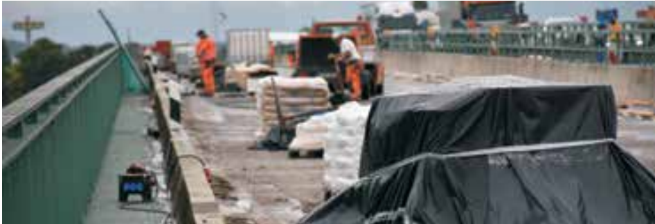
Die Baustelle auf der Rheinbrücke bei Mannheim-Sandhofen
