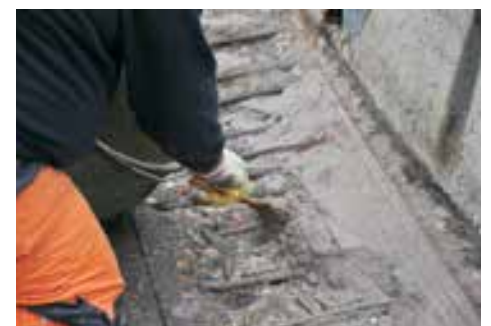
Alles Handarbeit: Damit der Stahl nicht rostet, wird Korrosionsschutz aufgetragen
