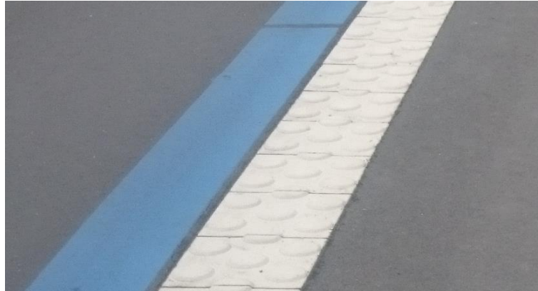
Abbildung 2: Trennung RSV zum Fußverkehr über taktile Elemente Bsp.: e-Radschnellweg in Göttingen (Foto: R+T)
